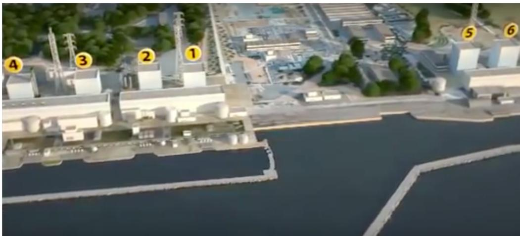
Durch die Flutwelle wurden in den Reaktoren die Kühlanlagen beschädigt, es kam zum Stromausfall, die Pumpen des Kühlkreislaufes wurden zunächst von Dieselgeneratoren versorgt. Diese fielen innerhalb von weniger als einem Tag aus.
